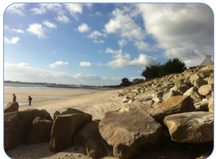
Figure 19 L'enrochement et l'épis de l'Ile-Tudy marquent la délimitation de la micro-cellule sédimentaire du Teven
