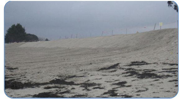
Figure 23 Travaux de rechargements sédimentaires Novembre 2011 Combrit
