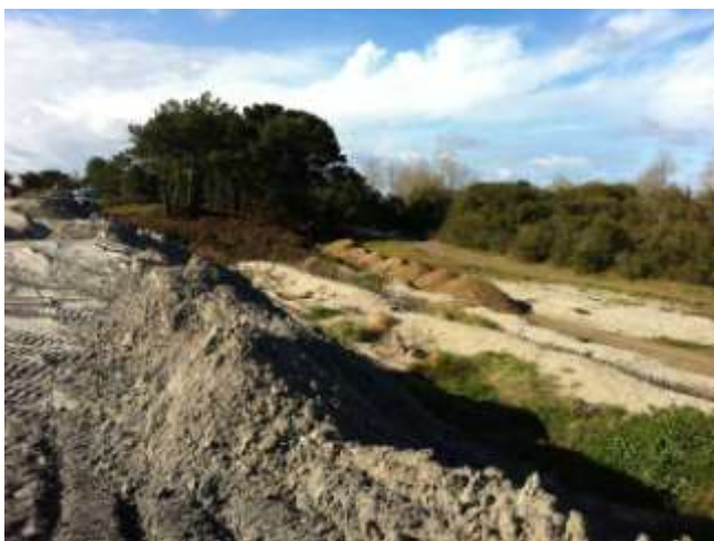
Photo 10 Le secteur 1 durant les travaux vu du secteur 2
