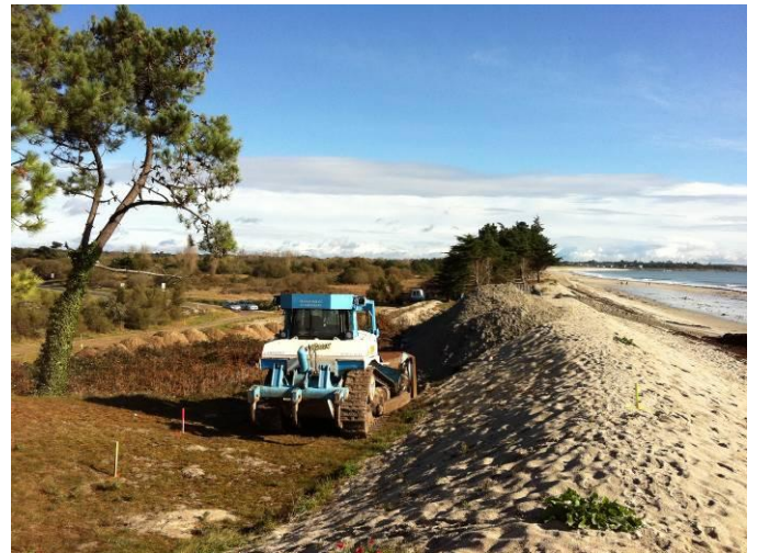
Photo 9 : Les grands travaux de 2011 le secteur en cours d'aménagement
