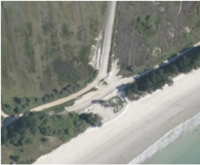
Photo 6 : Photo aérienne (IGN) du secteur malade post inondation de 2010 (pré travaux)
