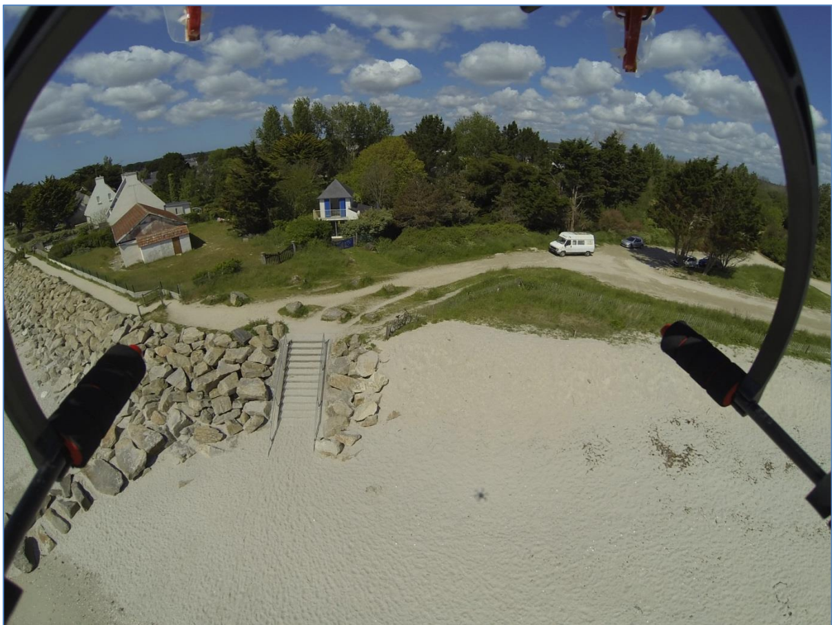
Figure 9 : Le drone "Wallee" en train d'observer la tête d'enrochement attaquée par la réflexion des énergies marines (Photo B. Guillot 25m mai 2014)
