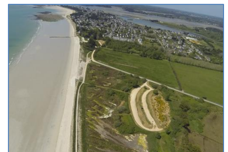
Figure 1 : Photo aérienne du Polder de Roscouré ou Polder de Combrit (B. Guillot 2014 120m), on y distingue la dune, dernier rempart de protection des habitations contre les tempêtes.
