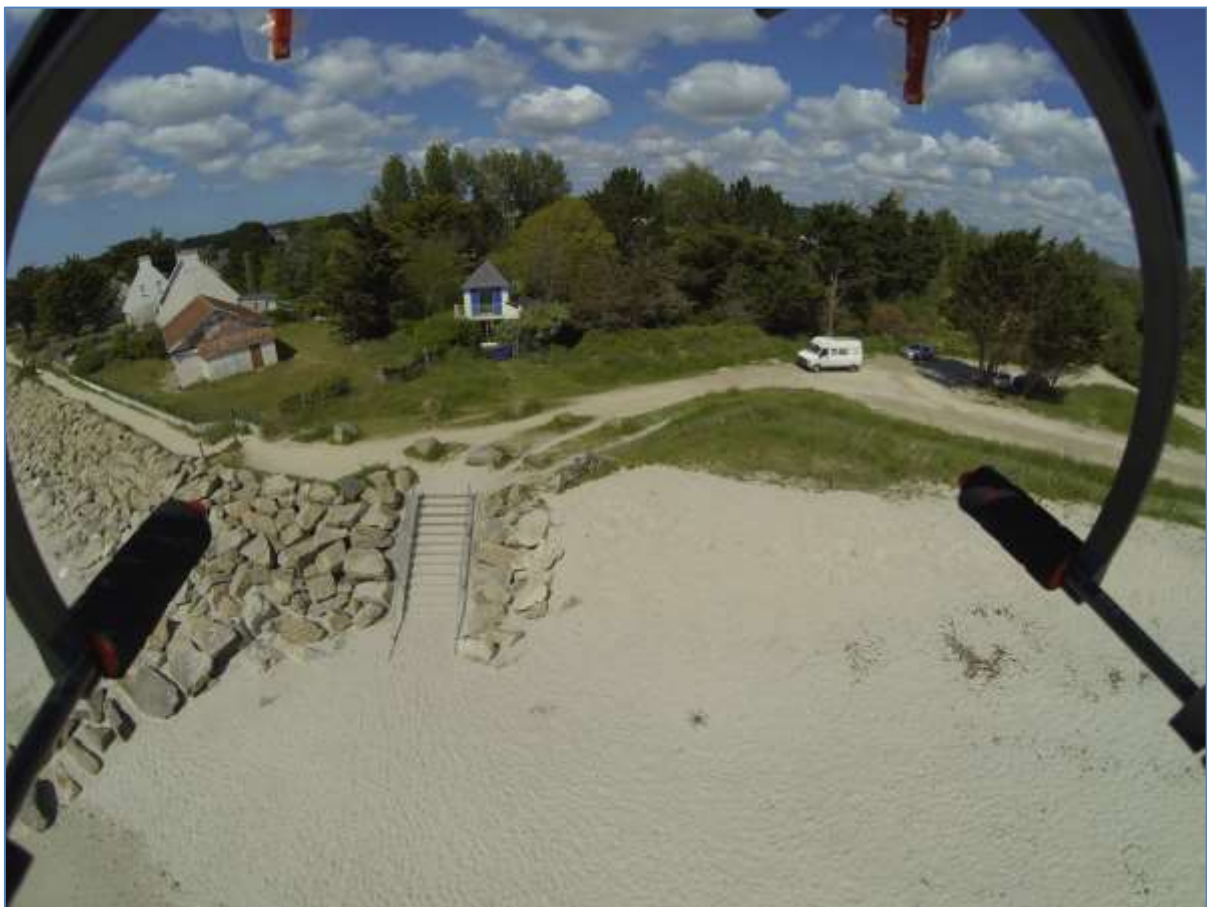
Figure 9 : Le drone "Wallee" en train d'observer la tête d'engrènement attaquée par la réflexion des énergies marines (Photo B. Guillot 25m mai 2014)
